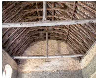
La charpente de la chapelle.
