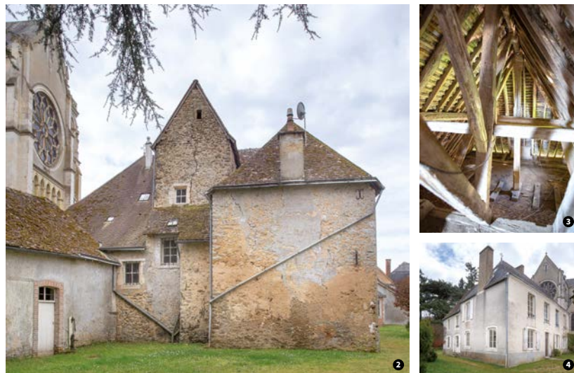
La place, l'ancienne église et le presbytère sur le cadastre de 1836 (Archives départementales de la Sarthe, 3 P 208) ❶. La façade arrière du presbytère et la tour d'escalier ❷. Un détail de la charpente du presbytère ❸. Les façades principales du presbytère ❹.
