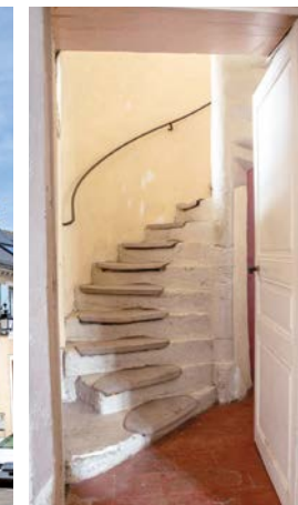
L'escalier à vis.
