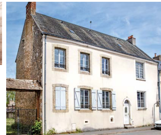
La maison du Grand Chardon côté rue.
