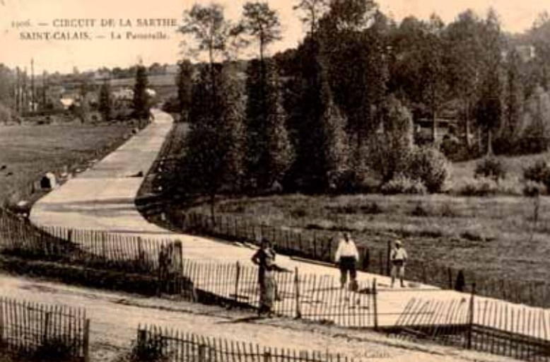
Construction de la route planchée à Saint-Calais. Coll. Arch. dép. Sarthe, 2F108990
