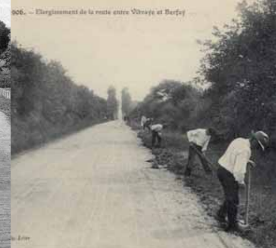
Élargissement de la route entre Berfay et Vibraye. Coll. Arch. dép. Sarthe, FRAD072_2Fi11082_00
