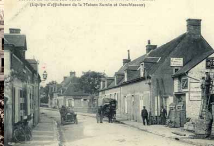
Traversée de Sceaux-sur-Huisne. Coll. Arch. dép. Sarthe, FRAD072_2Fi11084_00
