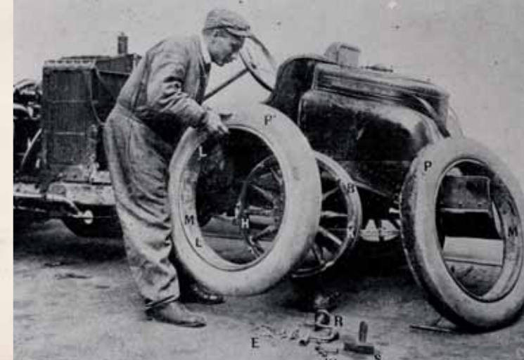
Extrait d'une notice explicative Michelin pour l'utilisation de la jante amovible. Collection A.C.O.
